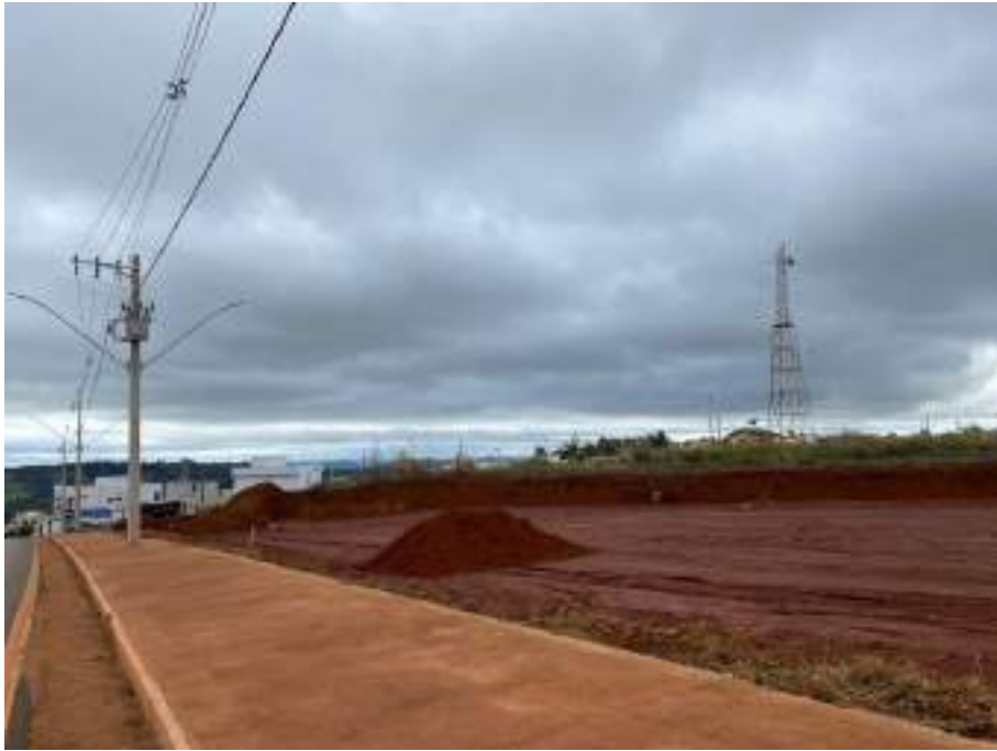
Imagem 5 -- Atual Situação da Obra
