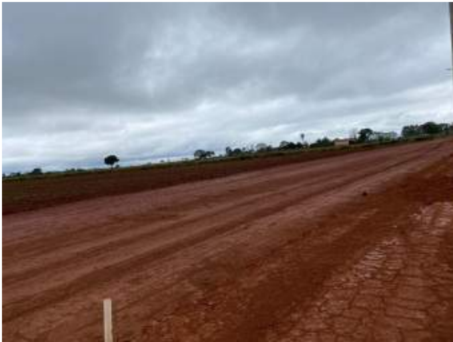
Imagem 6 -- Atual Situação da Obra
