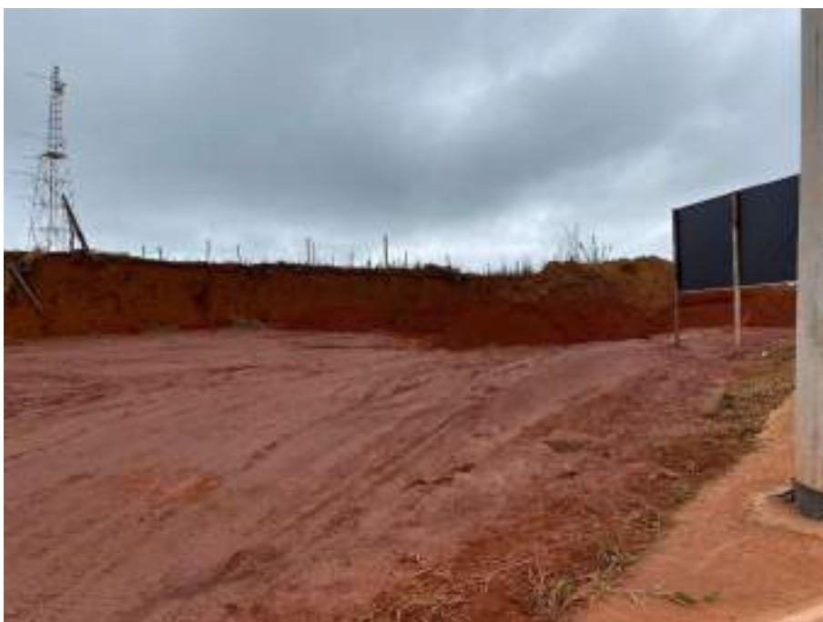
Imagem 2 -- Atual Situação da Obra
