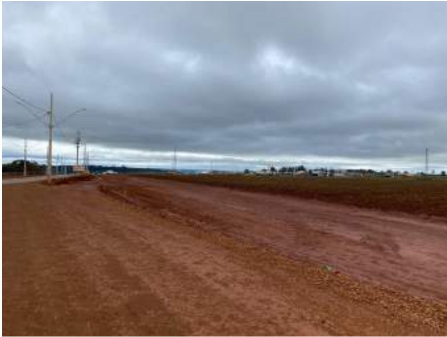
Imagem 9 -- Atual Situação da Obra
