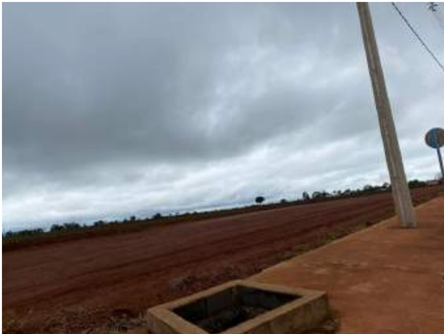
Imagem 4 -- Atual Situação da Obra
