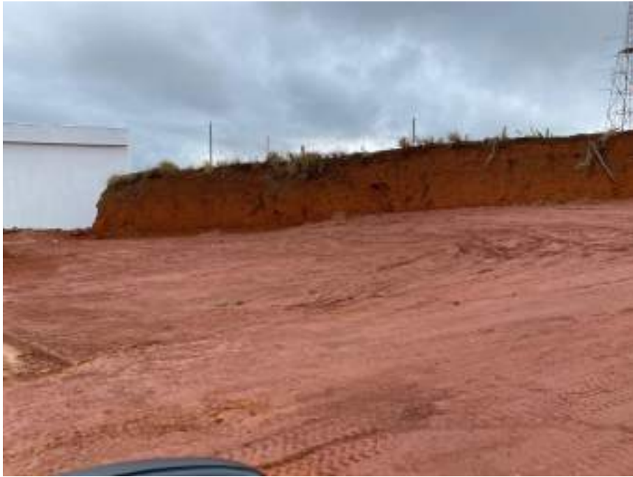
Imagem 3 -- Atual Situação da Obra
