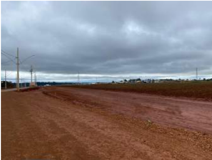
Imagem 1 -- Atual Situação da Obra
