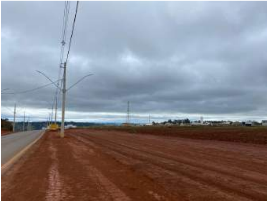
Imagem 7 -- Atual Situação da Obra
