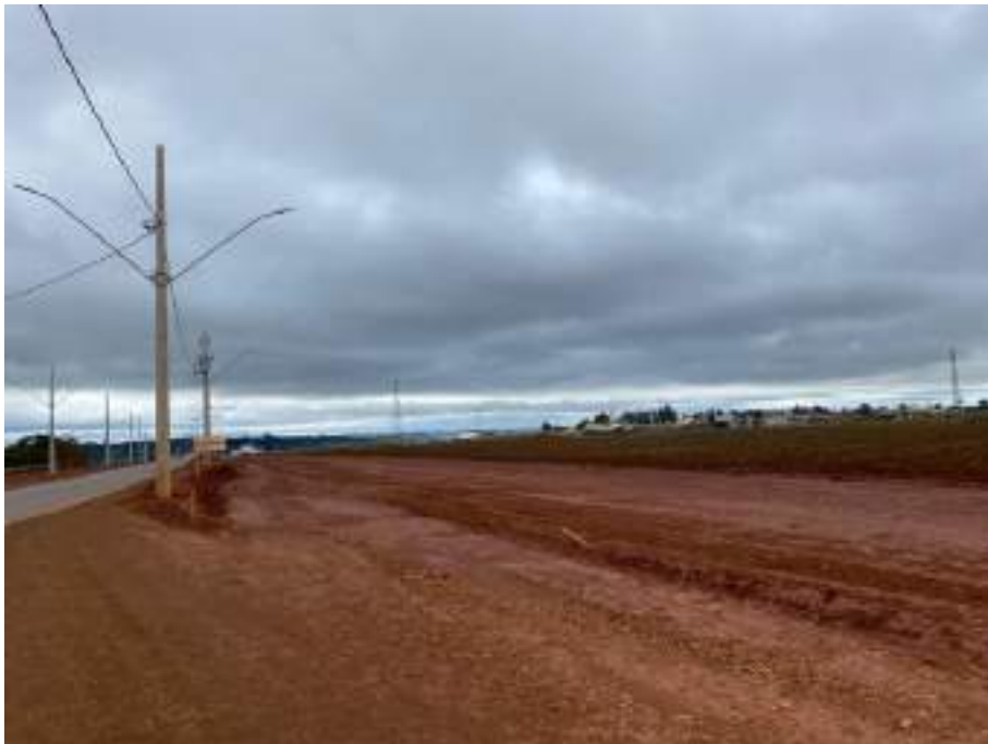
Imagem 8 -- Atual Situação da Obra
